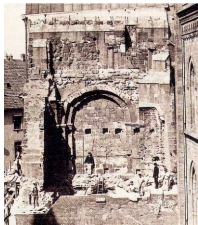
[3] Abriss der Südturmuine 1888
