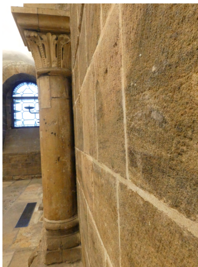
[29] Wandständige Säule(n) in der nördlichen Nische
