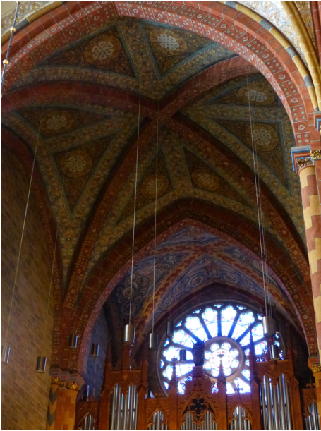
[45] Orgelempore/Westchor: ein Kreuzgratgewölbe, ein Badrippengewölbe
