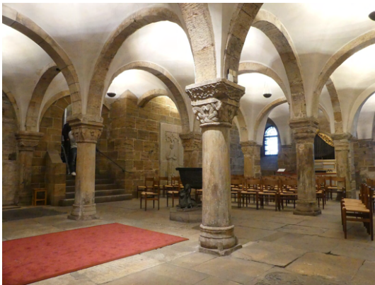
[25] Westkrypta nach Nordwesten
