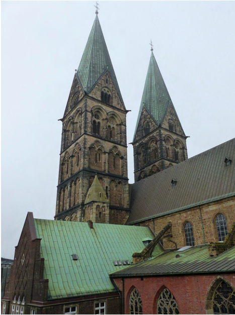
[57] Bremer Dom, Obergaden u. Türme
