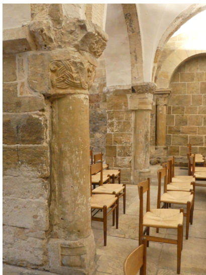
[28] Wandbündige Säulen an der ehemaligen Westwand
