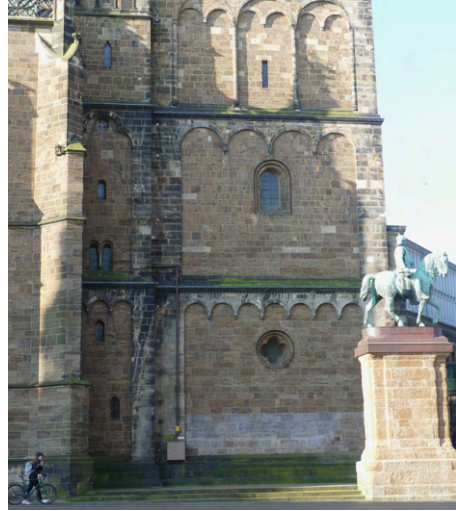
[44] Seit 1891/92 Erdgeschoss u. 1.OG mit Nordfenstern
