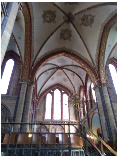
[48] Mittelschiff u. Chor Doppeljoche, Vierung und Querhaus vierteilige Gewölbe
