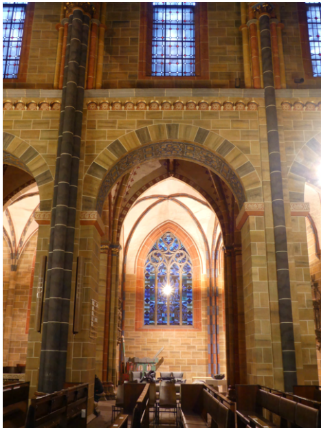
[59] Bremer Dom: Arkaden (hier Südarkade) mit wechselnden Lisenenbreiten
