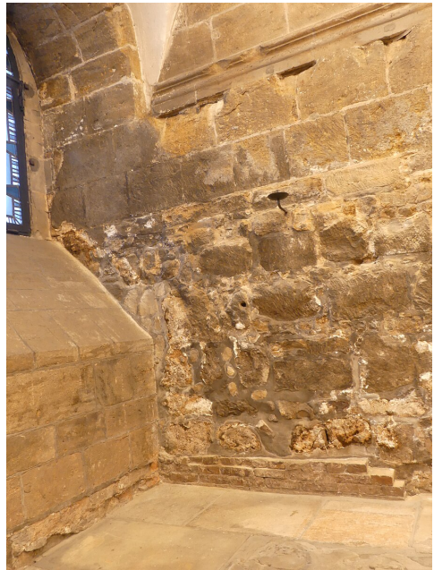
[37] Nachträglich vorgezogene Wand setzt sich in die ehemalige Türöffnung fort.
