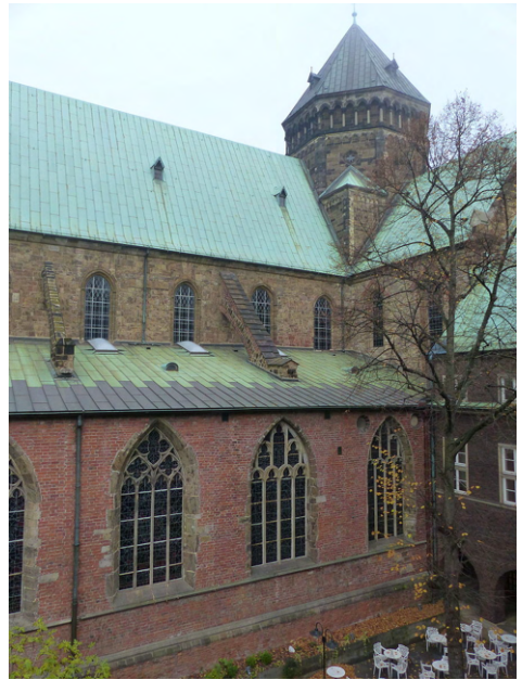
[58] Kapellenzeile, Querhaus, Vierung
