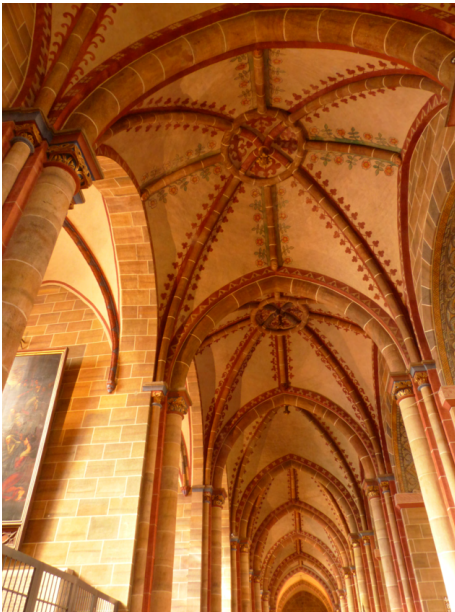
[47] Nordseitenschiff westfälische Gewölbe
