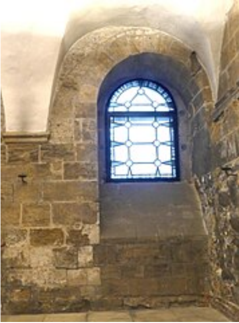
[36] Steinbogen in der Wand verschwindet rechts hinter stark gekrümmtem Gewölbe.
