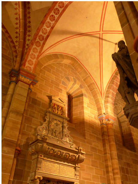
[46] Vorjoche u. Turm-Erdgeschosse: spitzbogige Kreuzgratgewölbe
