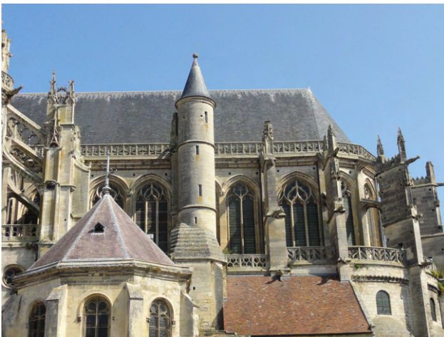
[62] Kathedrale von Senlis, Dép. Oise (F, Strebewerk nur an den Ecken der Doppeljoche
